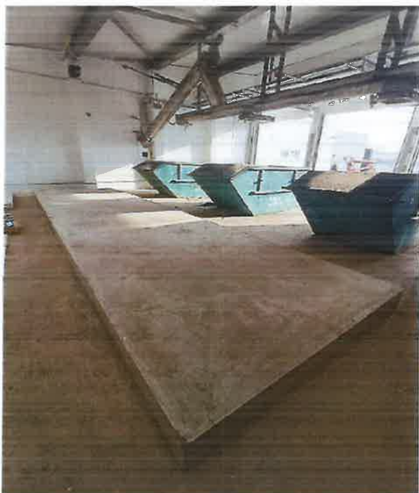
Slika 3. Izgradnja postrojenja za sušenje otpadnog mulja
