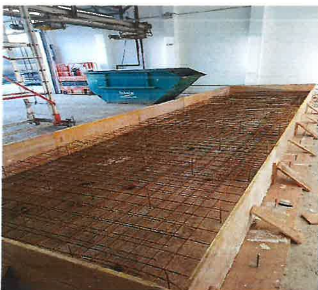
Slika 2. Izgradnja postrojenja za sušenje otpadnog mulja
